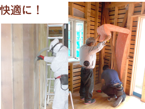
↑断熱材施工シーン↑
