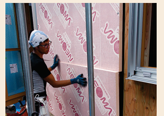
ネオマフォーム (断熱材) を施工中
